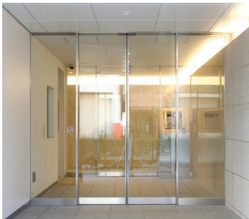
「SUS443J1」を使用した マンションエントランス建具の施工例 ( モンテベルデ ときわ台 ) 設計・施工 清水建設株式会社
