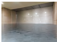
防水シャッター
