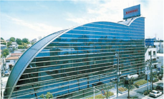
鈴木シャッター 本社ビル（東京）
