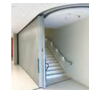
水平スライド式防火ドア(ODC)
