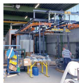
LED照明切り替え後
