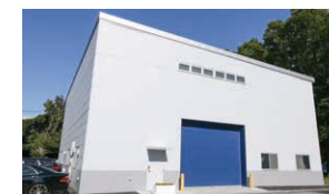
遮音試験棟建屋
