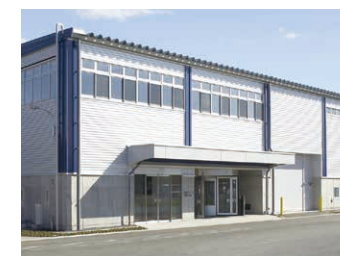
三和グループ 性能試験センター
