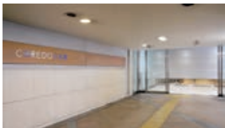
防水シャッター 施工写真 (コレド日本橋/日本橋一丁目三井ビルディング)
