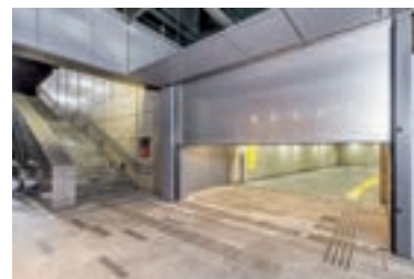
防水シャッター 施工写真 (三井住友銀行本店ビルディング)
