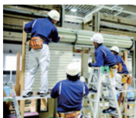
施工研修の様子
