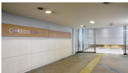
防水シャッター 施工写真 (コレド日本橋／日本橋一丁目三井ビルディング)
