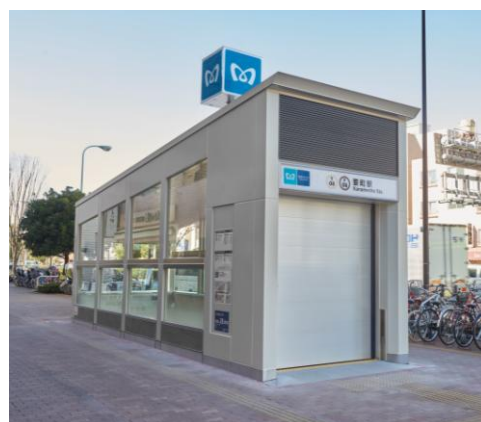
要町駅4番出入口に設置した防水シャッター(全閉)
