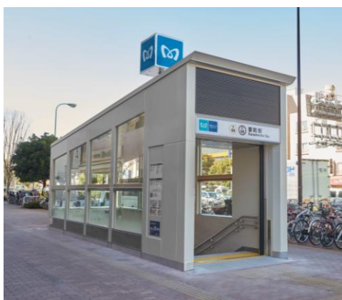
要町駅4番出入口に設置した防水シャッター(全開)
