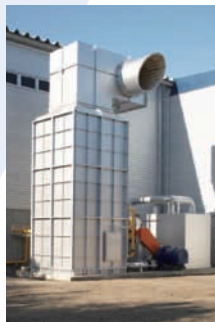
▲二次燃焼炉装置によって環境負荷を低減 ◀吸排気室のコンプレッサーと防音パネル
