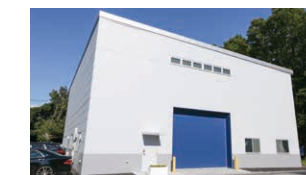
遮音試験棟建屋
