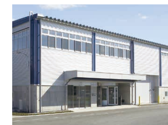
三和グループ 性能試験センター
