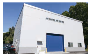
遮音試験棟建屋
