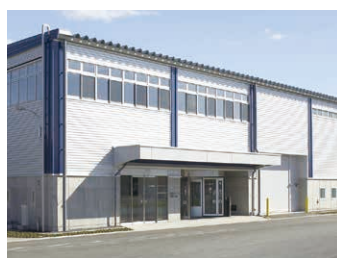
三和グループ 性能試験センター
