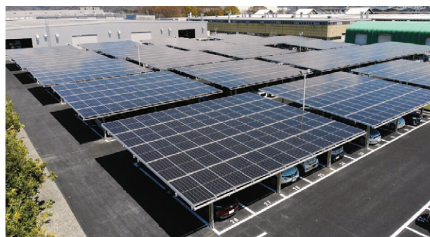
太田ドア工場ソーラーカーポート
