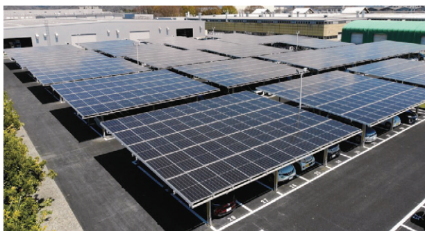
太田ドア工場ソーラーカーポート
