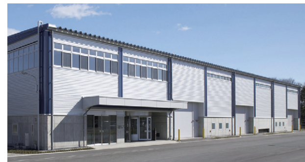
三和グループ性能試験センター
