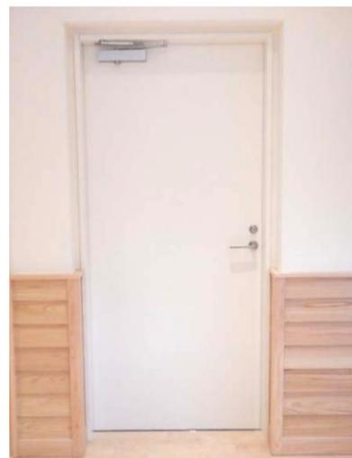
「灼熱ガード」は、火災時の避難経路や消防隊の進入経路の安全確保と火災の延焼拡大を防止するため、遮炎性能に加えて、国内では業界初\*の”遮熱性能”を有する特定防火設備(60分防火設備)として開発しました(特許出願済)。操作性や意匠は一般的なスチールドアと同等でありながら、扉内や枠内に遮熱材を充填することで高い遮熱性能を確保し、ISO(国際規格)に規定された遮熱性能判定基準を満たしています。
