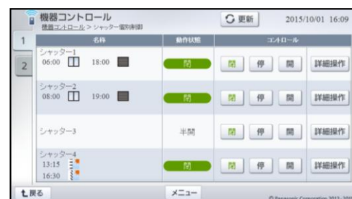
電動窓シャッター 個別制御TOP画面
