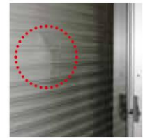
屋内側（サッシ側）： ガラスの破損なし
