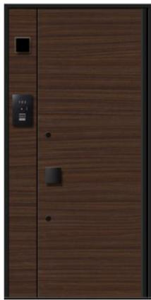
従来の性能・意匠性を損なうことなく、危険を察知できない子どもが不用意に指を差し込み、ケガをしないよう配慮したドアです。扉内に回転軸を設けた中心吊方式にし、扉の表面吊元側では凸形状を設けています。また、扉の内面ではスポンジゴムを設けています。それにより、開閉時に指を挟みにくい構造になっており、安全性に配慮しています。第8回で受賞した『マンションドア指はさみ防止仕様』は扉内面のみにおいてでしたが、今回の仕様は扉の内外において子どもへの安全配慮を実現しました。
