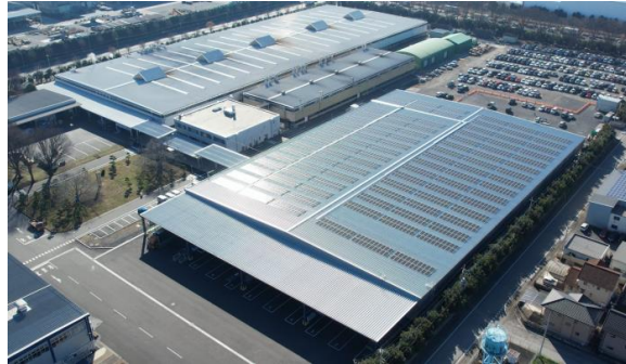
2021年12月 三和シャッター工業 太田ドア工場 物流棟に太陽光発電設備を導入
